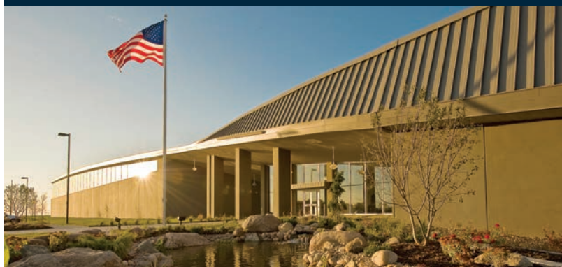
Planta de Tratamiento de Agua “Platte West”
