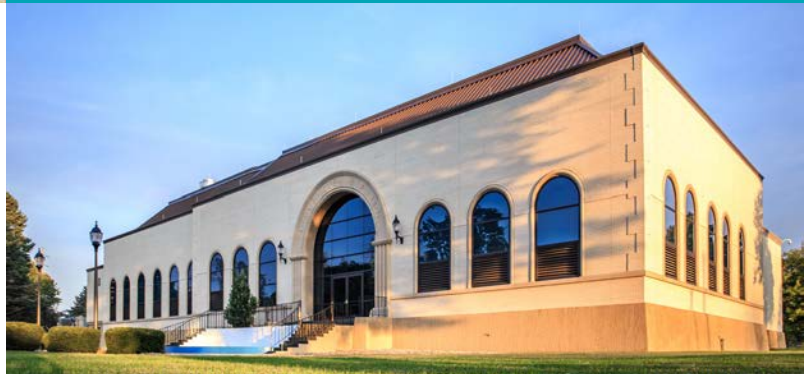
Planta de Tratamiento de Agua “Florence”
