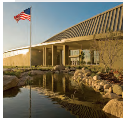
Planta de Tratamiento de Agua "Platte West"
