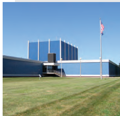
Planta de Tratamiento de Agua "Platte South"
