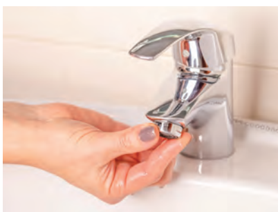
Remueva y limpie las boquillas de los grifos (mallitas) regularmente.
