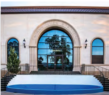
Planta de Tratamiento de Agua "Florence"
