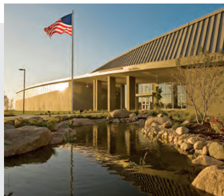
Planta de Tratamiento de Agua "Platte West"
