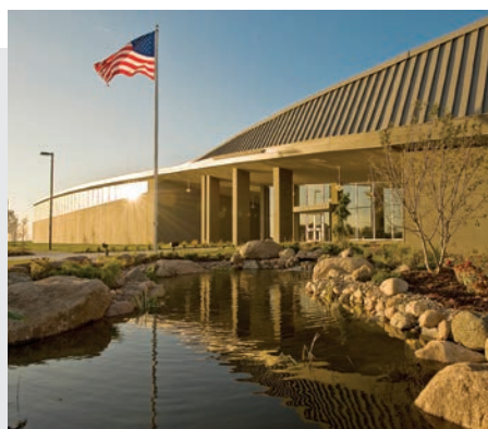
Planta de Tratamiento de Agua "Platte West"
