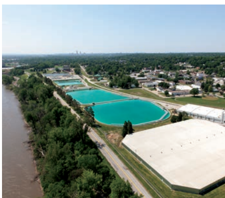
Planta de Tratamiento de Agua "Florence"
