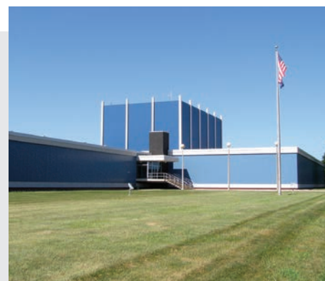
Planta de Tratamiento de Agua "Platte South"
