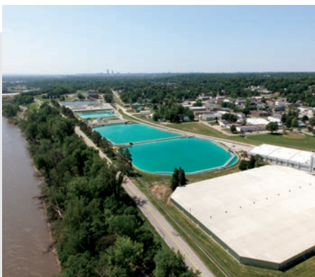
Planta de Tratamiento de Agua "Florence"
