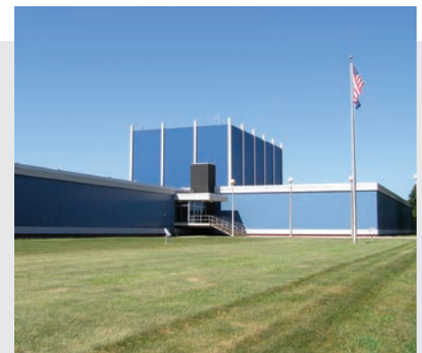
Planta de Tratamiento de Agua "Platte South"
