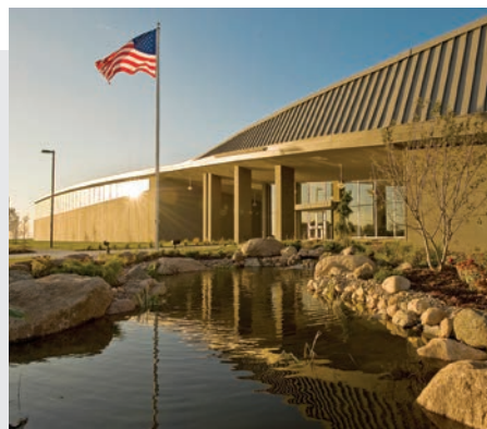
Planta de Tratamiento de Agua "Platte West"
